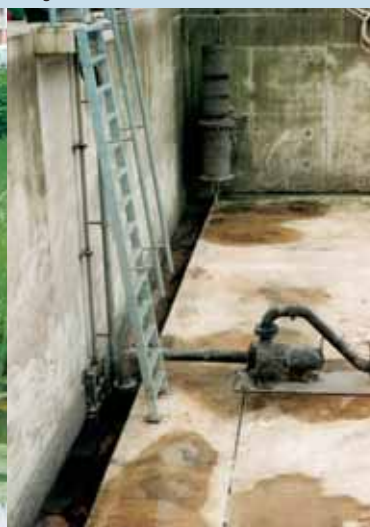
Bergbezinkbassin in aanbouw
